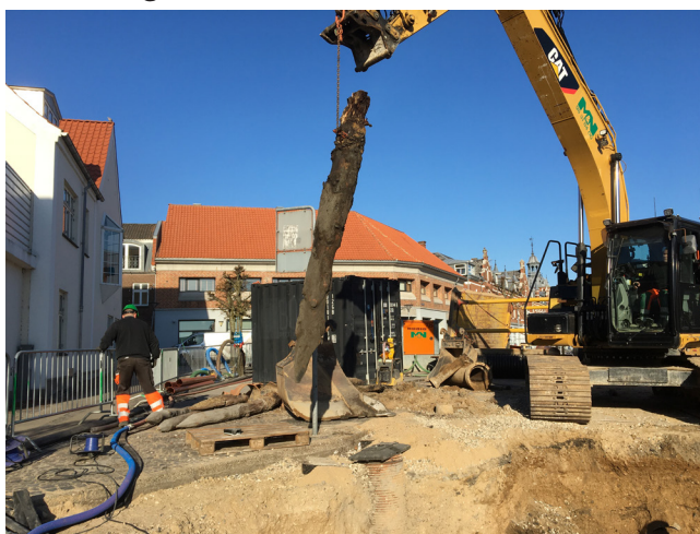
Figur 4. En af de mange piloteringspæle fra ejendommen Adelgade 5 er her netop blevet trukket op af maskinen.
