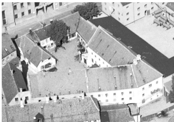
Figur 5. Luftfoto af ejendommen Adelgade 5 taget i 1950'erne. Efter Aero Ekspress; Det Kgl. Bibliotek.
