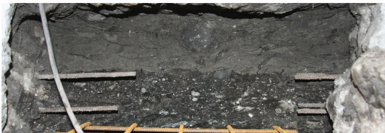
Figur 4. Tydelig overgang mellem lagene i kystdiget A20 set fra syd.
