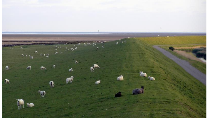
Figur 6. Moderne havdige i Sønderjylland. Bemærk den vandfyldte grøft langs bagsiden af diget som stammer fra opgravningen af sand og ler til digefyldet.
