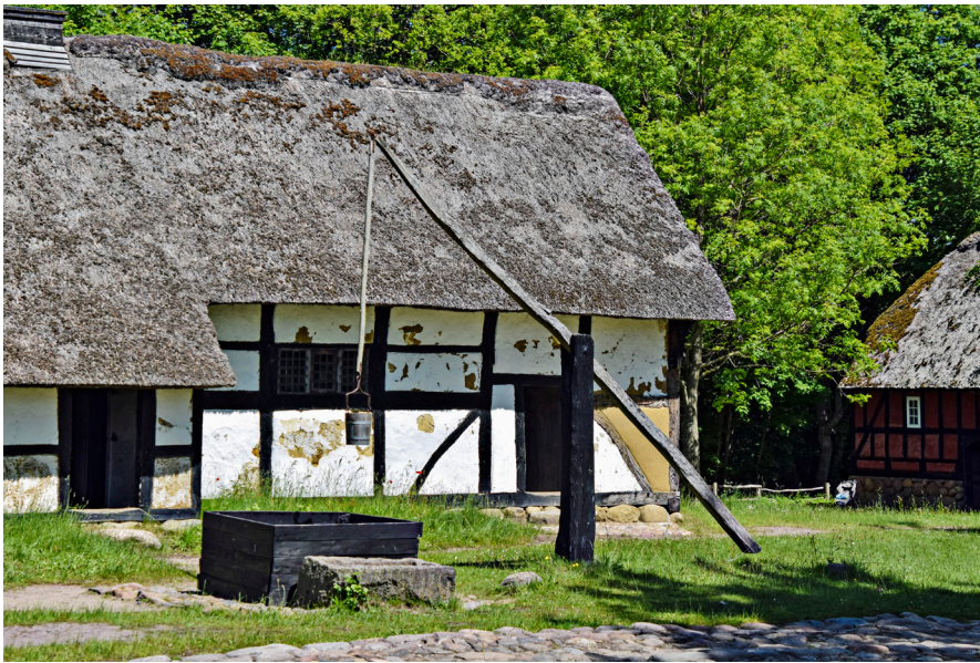
Fig. 4: Vinkelgården på Hjerl Hede. Den ældre bygning har måske været meget lig denne gård.
