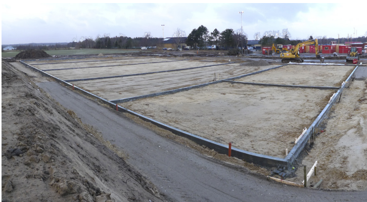
Byggeriet af magasinhallen, som det så ud i starten af februar. Fundamentet er støbt, og inddelingen i 5 haller er tydelig. Foto: Jan Slot-Carlson.
