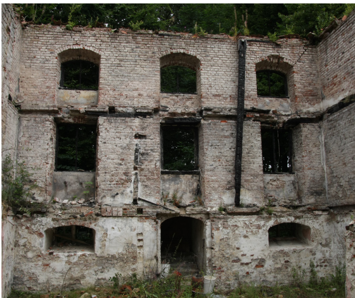
Den nordlige gavl med oprindelige vinduesåbninger og den oprindelige kældernedgang. Set fra syd.
