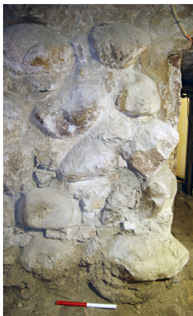
Kampestensfundamentet i østfløjens østlige mur. Set fra øst Foto: Bente Springborg.
