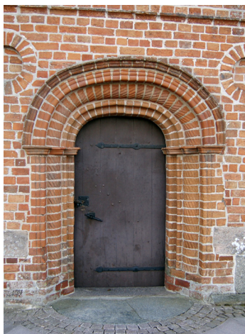
Astrup Kirke, kurvehanksbuet prydstik over indgangen til våbenhuset. Set fra nord.
