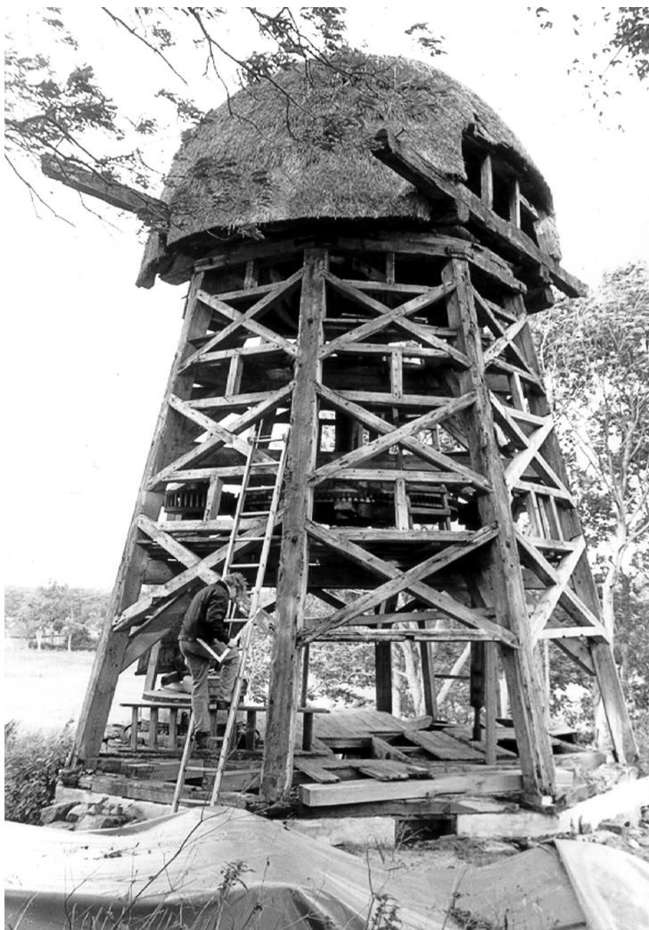
Havnø Mølle kom til i 1994. Restaureringen af Nordjyllands ældste vindmølle var museets hidtil største enkeltprojekt.
