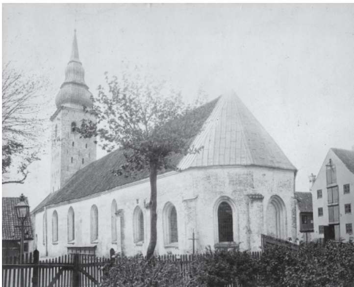
Den gotiske Vor Frue kirke før nedrivningen i 1877. Billedet er taget fra sydøst, så kirkens brøstfældige sydmur ses. Foto: Aalborg Stadsarkiv.
