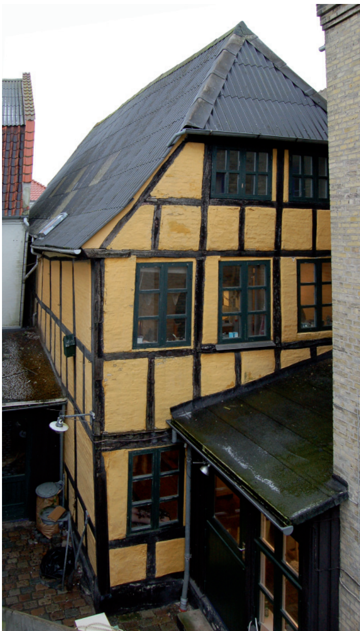
Gavlhusets bagside 2007 før nedrivningen. Ved bagsiden træder husets virkelige karakter frem. Højstolperne, der går fra bund til tag i langsiden, er et typisk renæssancetræk. Sydgavlens bindingsværk er omsat i senere tider med en delvis genanvendelse af det oprindelige tømmer.
