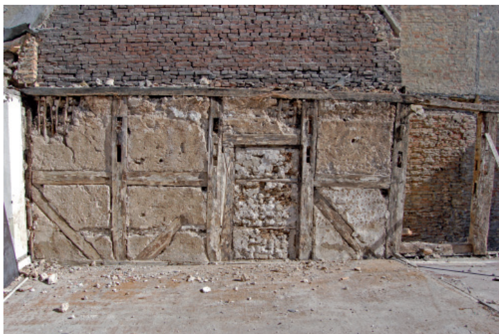
Den bedst bevarede del af det nedrevne gavlhus, hvor den oprindelige lerklining var bevaret. Der er tale om 1. salens forreste fag mod Algade i den østlige langside. Læg mærke til den afblændede dør, der har givet adgang til en udvendig svailegang eller en sidebygning langs Algade.
