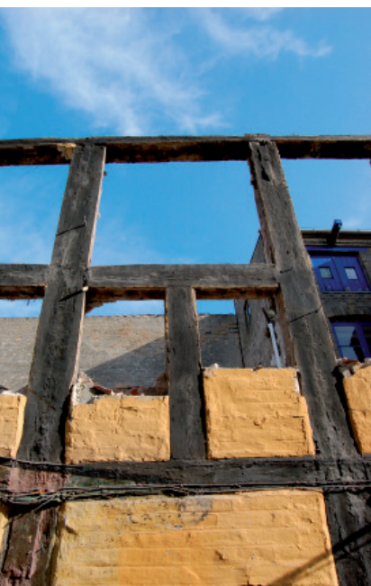
Vestsiden af Algade 9 under nedbrydning. Gulmalede tavler mellem to sorttjærede, bærende højstolper. Foto: Stig B. Møller.
