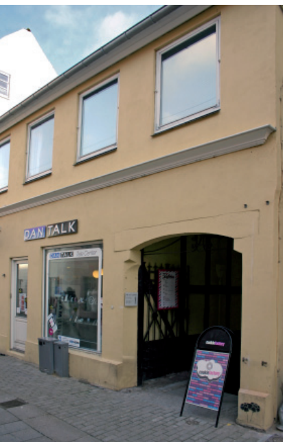
Kontrasten mellem de gamle bygningsdele og nyere renoveringer er ofte stor. Her et eksempel fra Nørregade. Termovinduer og bindingsværk. Foto: Morten Pedersen
