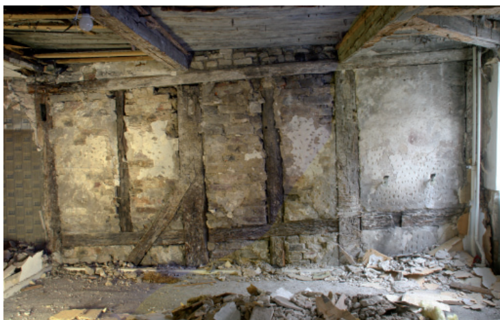
Den østlige mur på 1. salen af Algade 8. 3 fag bindingsværk var bevaret, og der sås spor efter ranker, som var bladet på indersiden af konstruktionen. Bindingsværket på Algade 8 mindede om konstruktionen på Algade 5, hvorfor en datering af Algade 8 til 1550-1600 er sandsynlig. Foto: Christian V. Jensen.
