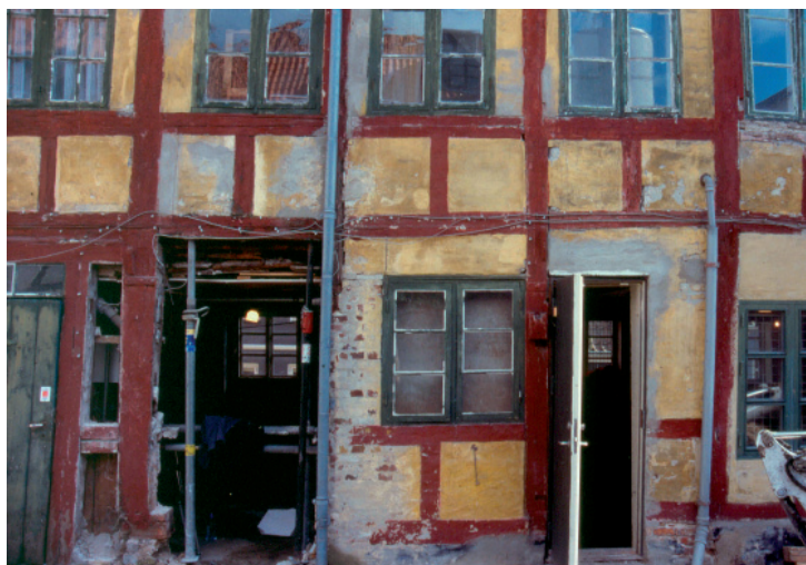
Gårdsiden af Hjelmerstald 2 under renovering i 2004. Foto: Christian V. Jensen.
