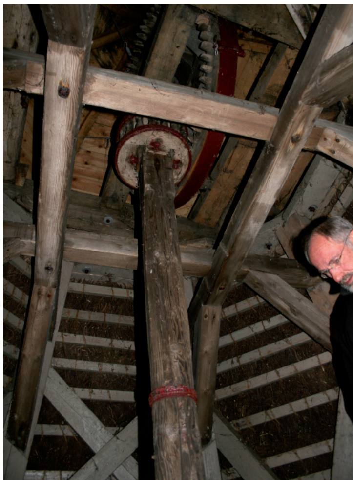
Det indre af Grønnestrand Mølle. Der er direkte træk fra krondrevet til møllestenen som i en stubmølle.
