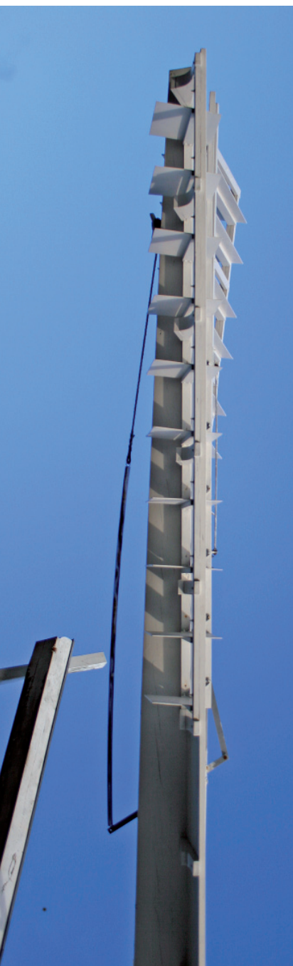
Klapperne på Øster Sundby Møllens vinger reguleres af lange fjedre, der sidder på vingens bagside. Det er den eneste fjedersvikkede mølle, der er bevaret i Danmark.
