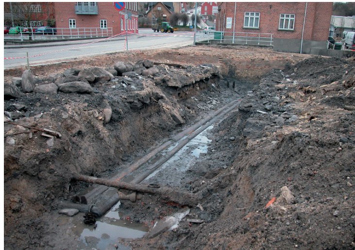
Figur 6. Langs Adelgades sydøstlige side afsløkkedes to parallelt liggende vandrør anlagt i tiden omkring 1800. I baggrunden ses rækverket til den nuværende bro over Onsild Å.
