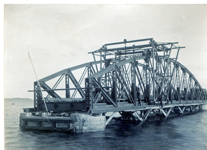
Montering af det søndre 40 m's fag den 3. oktober 1904.
