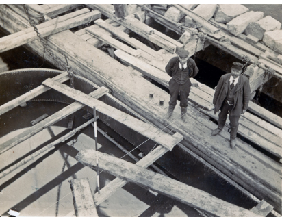
Ingeniør Asger Rye Clausen (t.v.) overvåger nedsætningen af søndre anslagspillecaisson den 12. august 1903.
