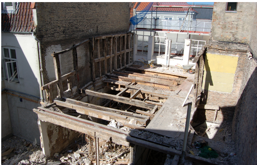
Billede fra nedrivning i 2007 af bygningen Algade 9.
