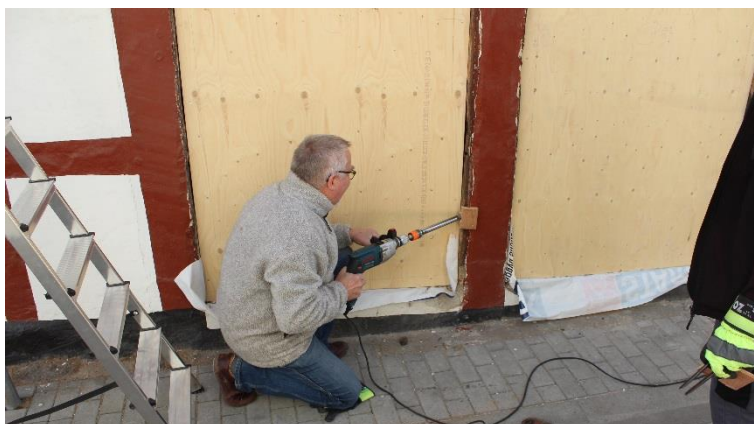
Der udtages boreprøver fra den stående bygning til dendrokronologisk datering. Den nuværende bygning viste sig at være opført i 1680'erne.
